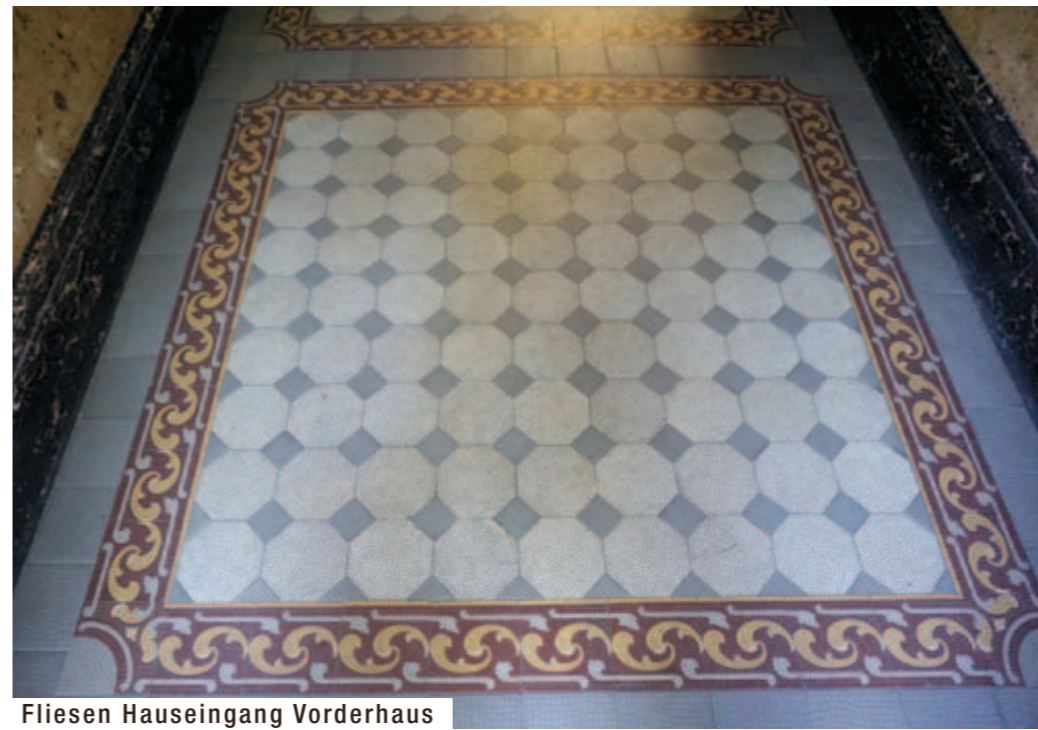
Fliesen Hauseingang Vorderhaus
