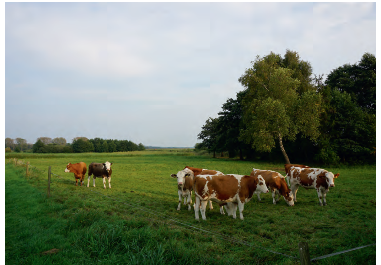
Blick auf den Deich und die Peenestraße, der Deich wurde nach einem Hochwasser im Jahr 1954 errichtet und 1960, 1980 sowie zuletzt 2005 erhöht
